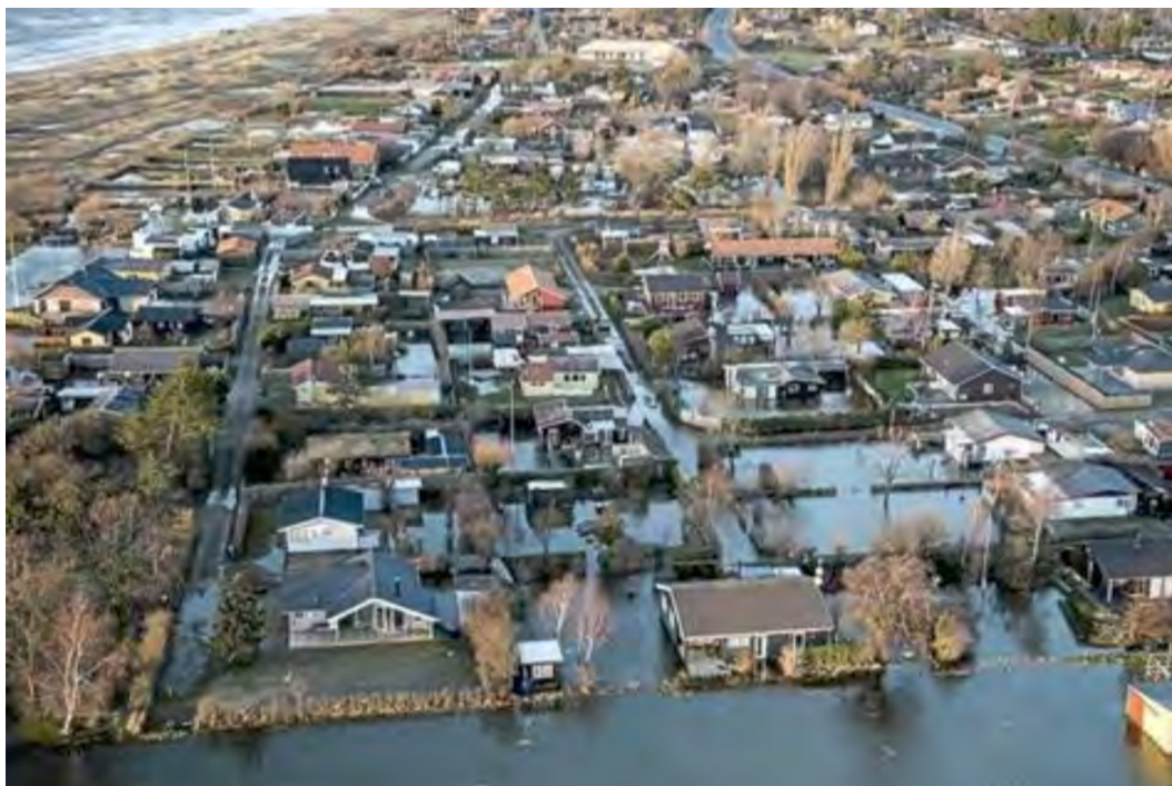
Oversvømmelse ved Næsby Strand, nord for Korsør, efter stormen Bodil i 2013
